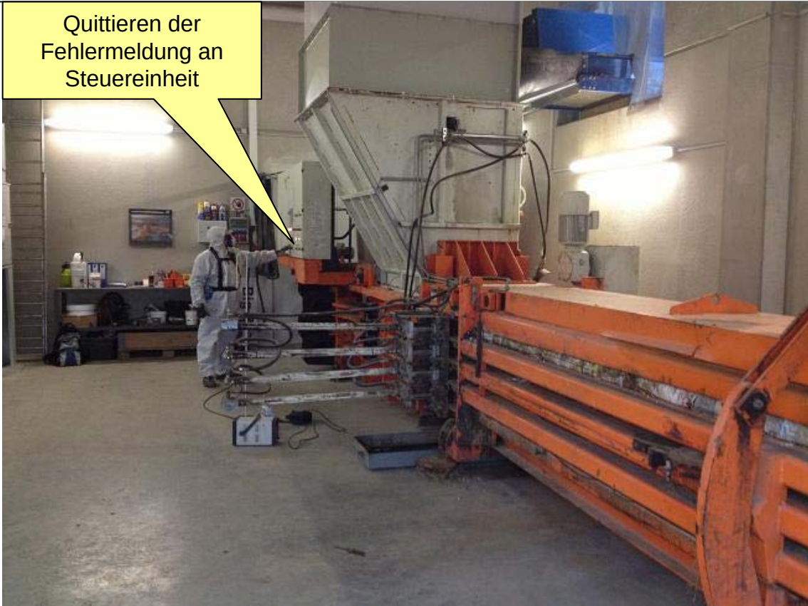
Bild 10: Arbeiten außerhalb der Presse durchgeführt (Nr. 11)
