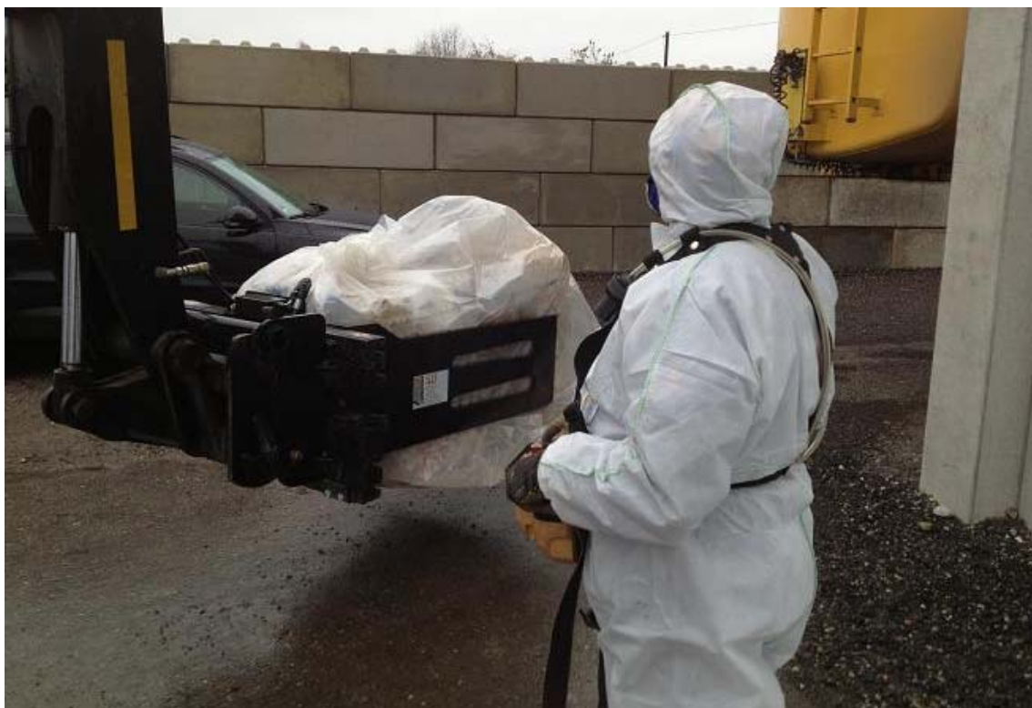
Bild 9: Verpackten Bündel mit Hilfe Greifstapler abtransportiert (Nr. 10, 14, 18)
