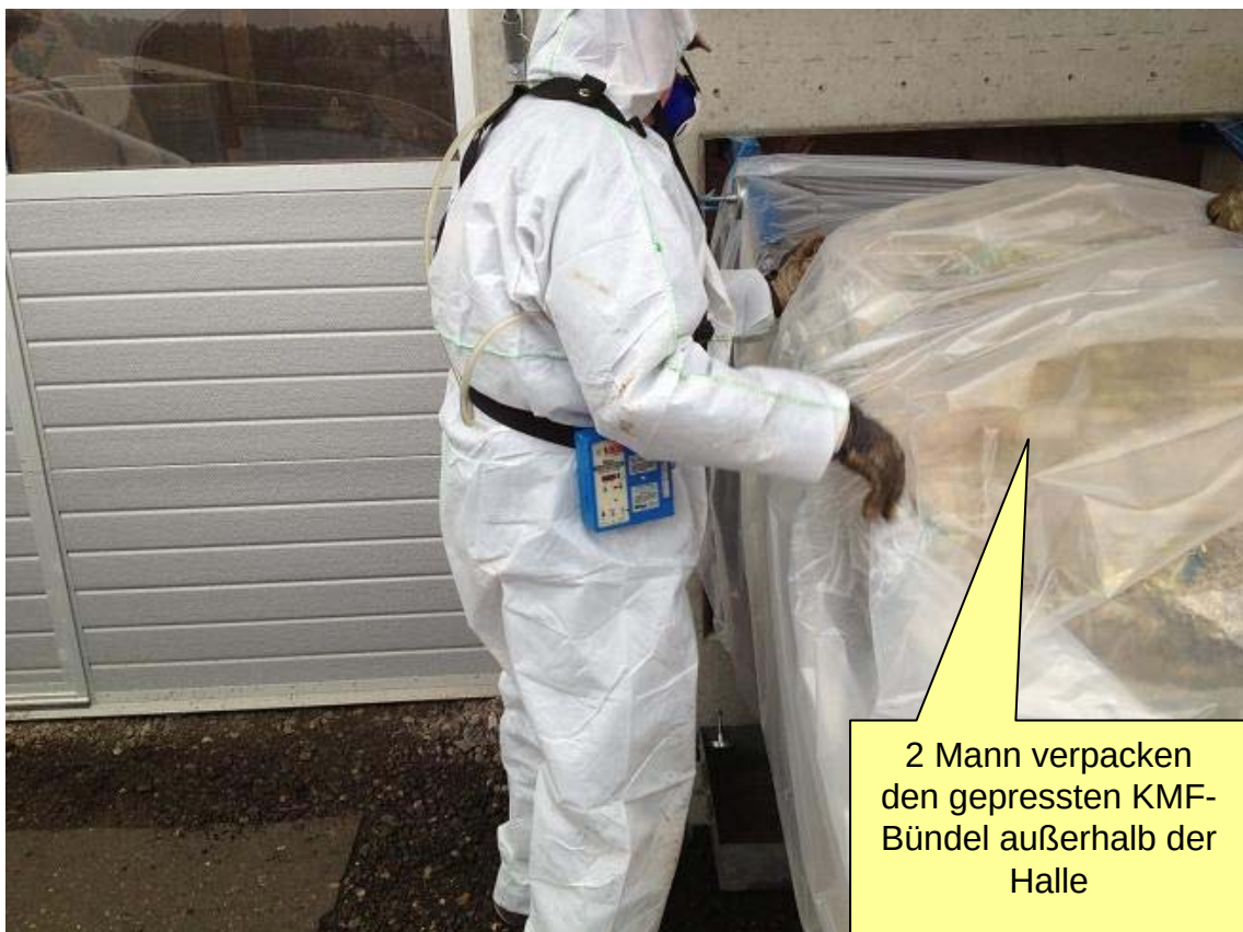
Bild 7: Verpacken des Bündels (Nr. 8, 12, 16)
