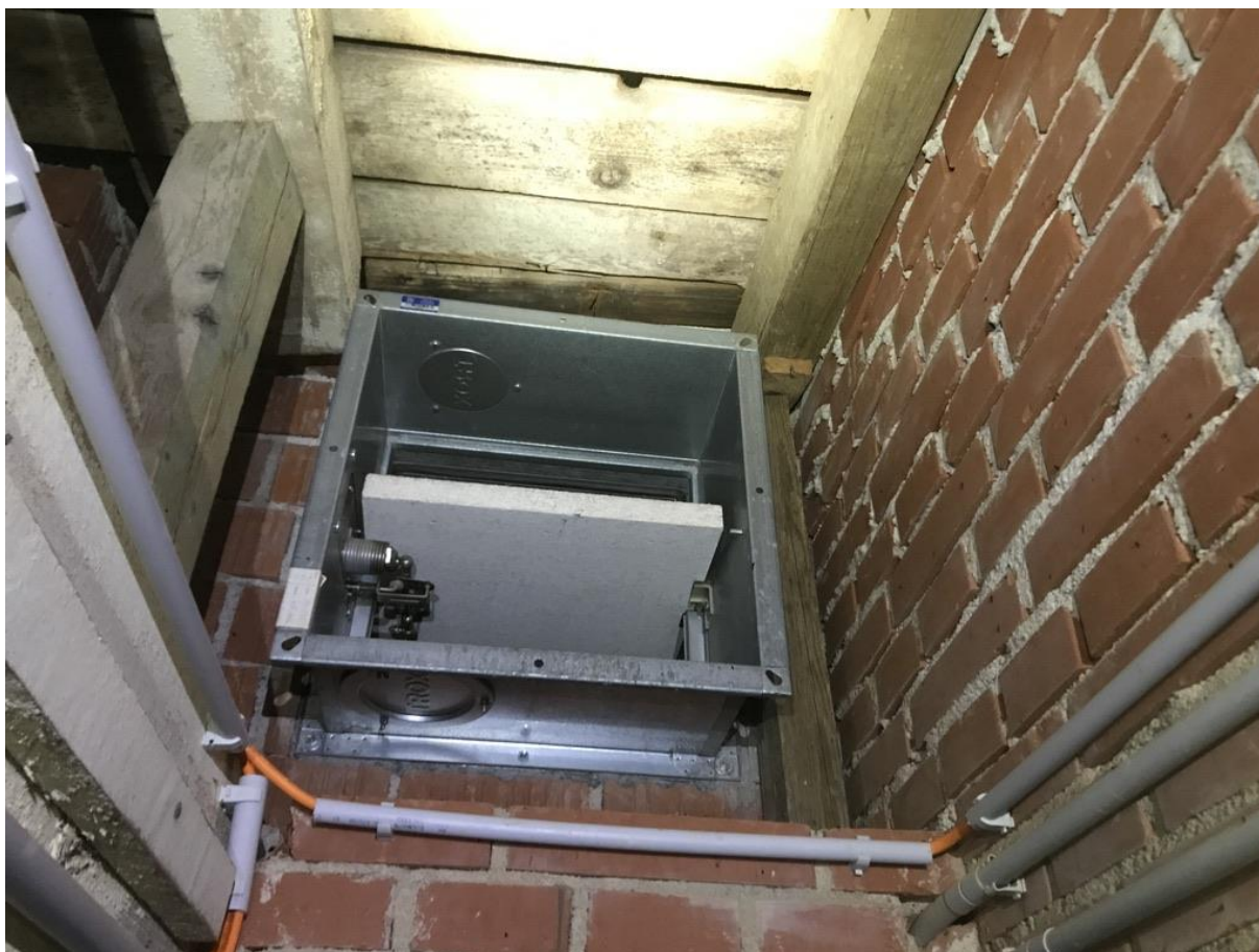
Abbildung 4-7: Aus Gründen des Brandschutzes mussten die Flugwege der Wimperfledermaus zwischen verschiedenen Gebäudeteilen mit Brandschutzklappen versehen werden, Foto: U. Hüttmeir
