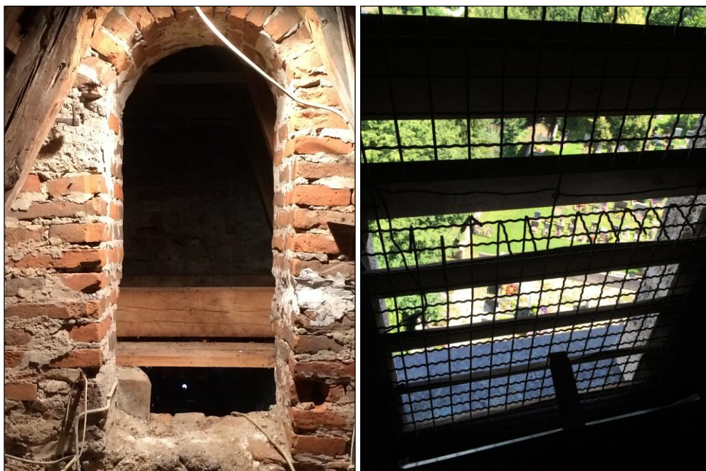
Abb. 18, 19: Durchflug zwischen Turm und Dachboden, vergitterte Schallluken
