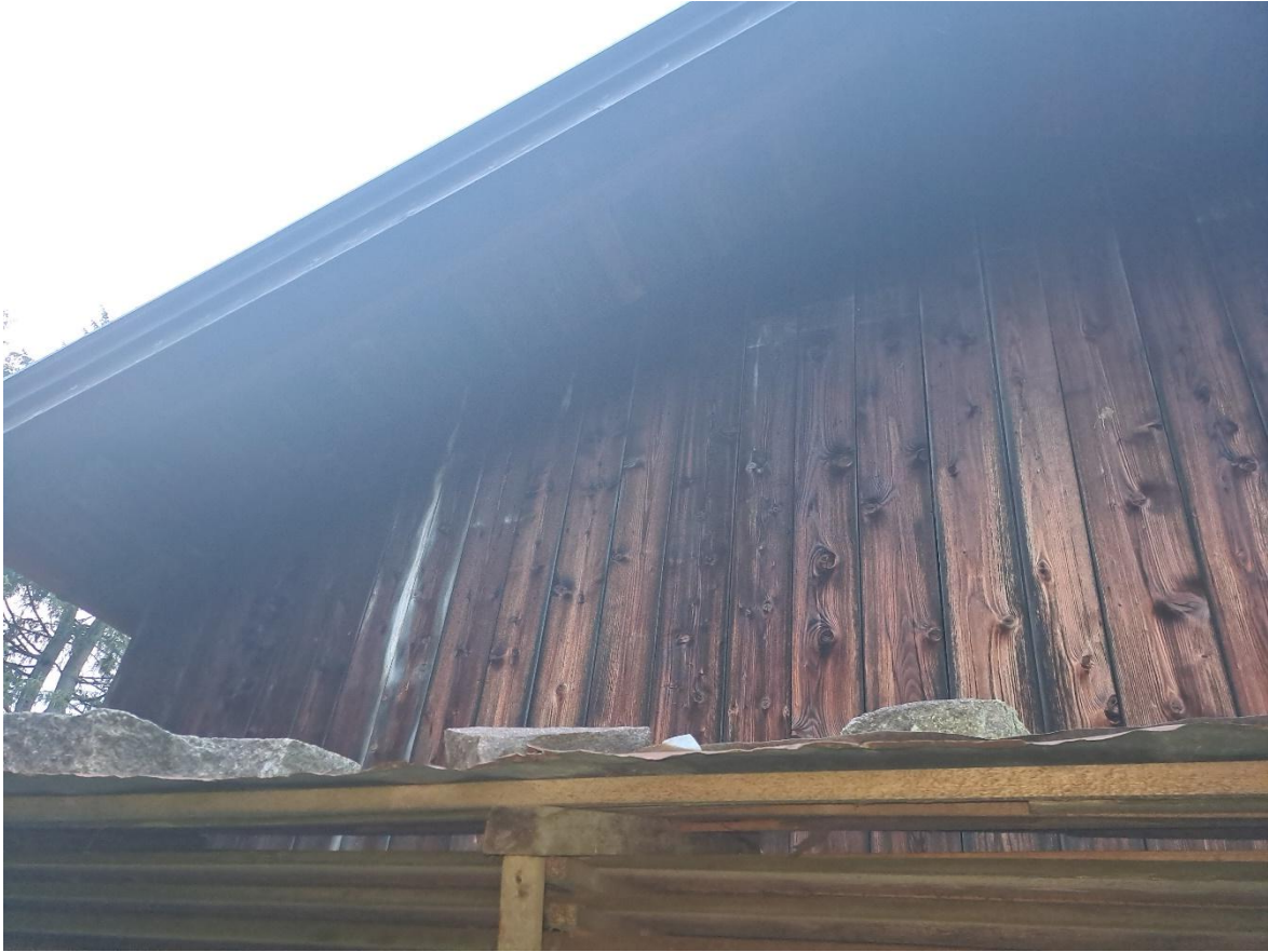
Abbildung 5: Verfärbte Balken an der Ostseite von Stadl Nr. 10. Die Verfärbung kann von Urinspuren herrühren und lässt auf Nutzung durch Fledermäuse schließen.
