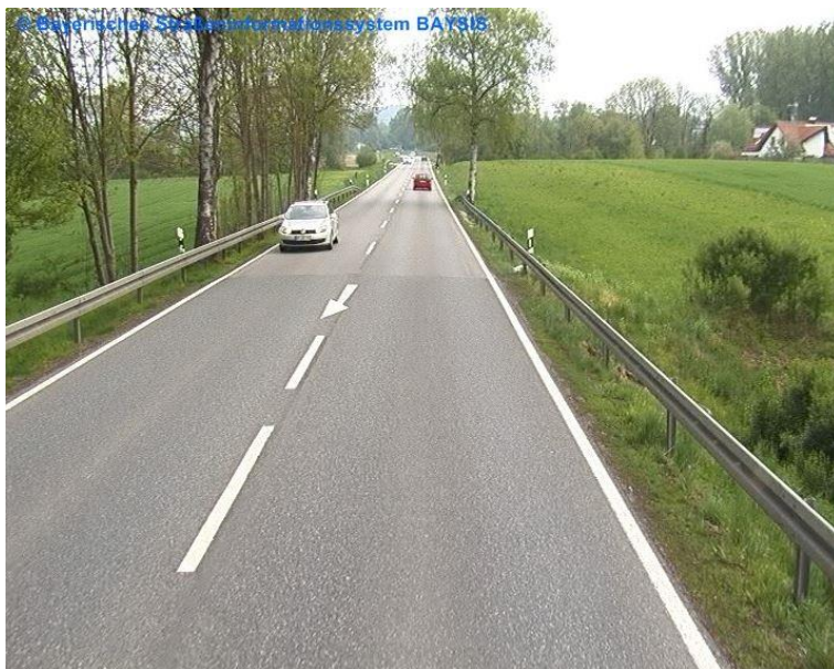
B 2 mit zweistreifigem Querschnitt, Fahrbahnbreite 7,50 m
