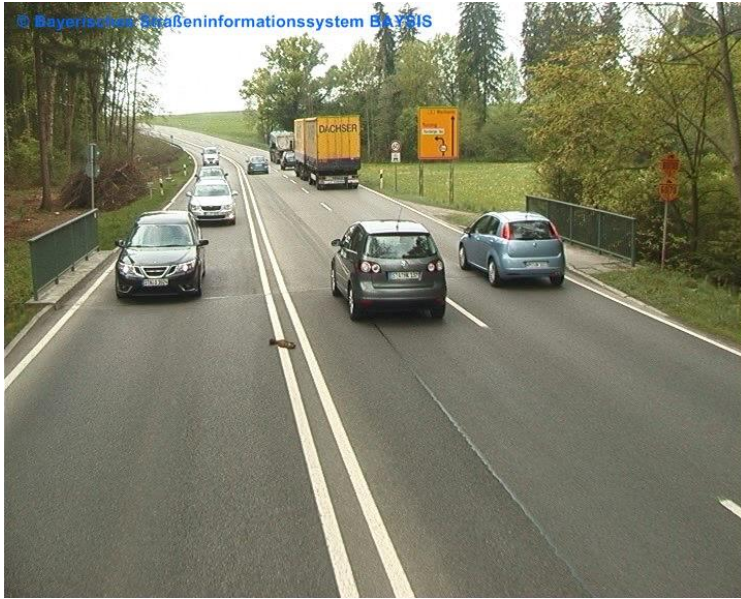
B 2 mit dreistreifigem Querschnitt, Fahrbahnbreite 11,00 m
