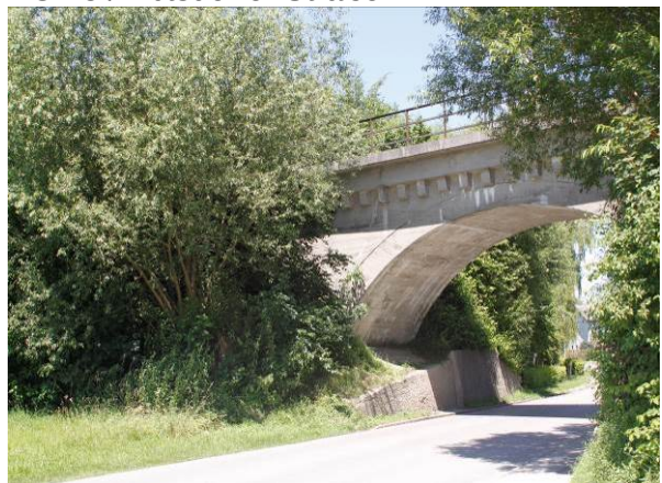
Foto 16: Bahndammunterführung Kreisstraße BGL 3 / Abtsdorfer Straße
