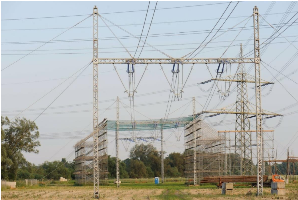
Abbildung 13 Einsatz von Provisorien (380-kV-Freileitungsprovisorium für ein System, mit errichtetem Schutzgerüst (Hintergrund))
