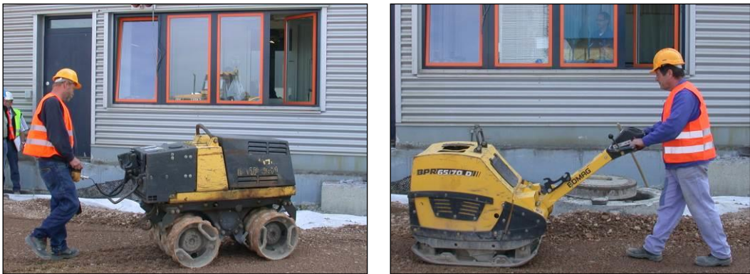
Abbildung 4. Links: Grabenwalze Bomag; rechts: Bomag BPR 65/70D.
