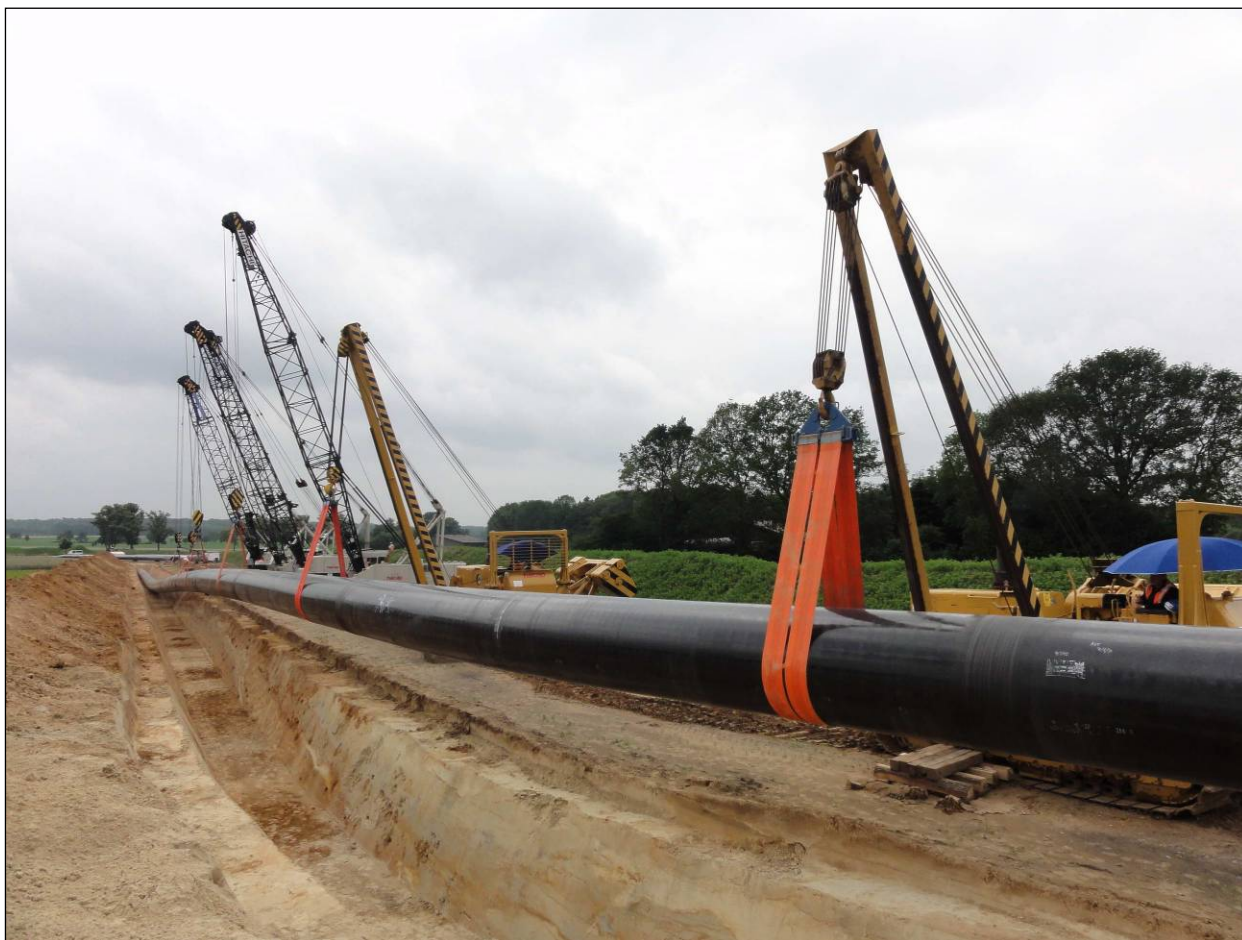
Abbildung 8: Absenken des Rohrstranges
