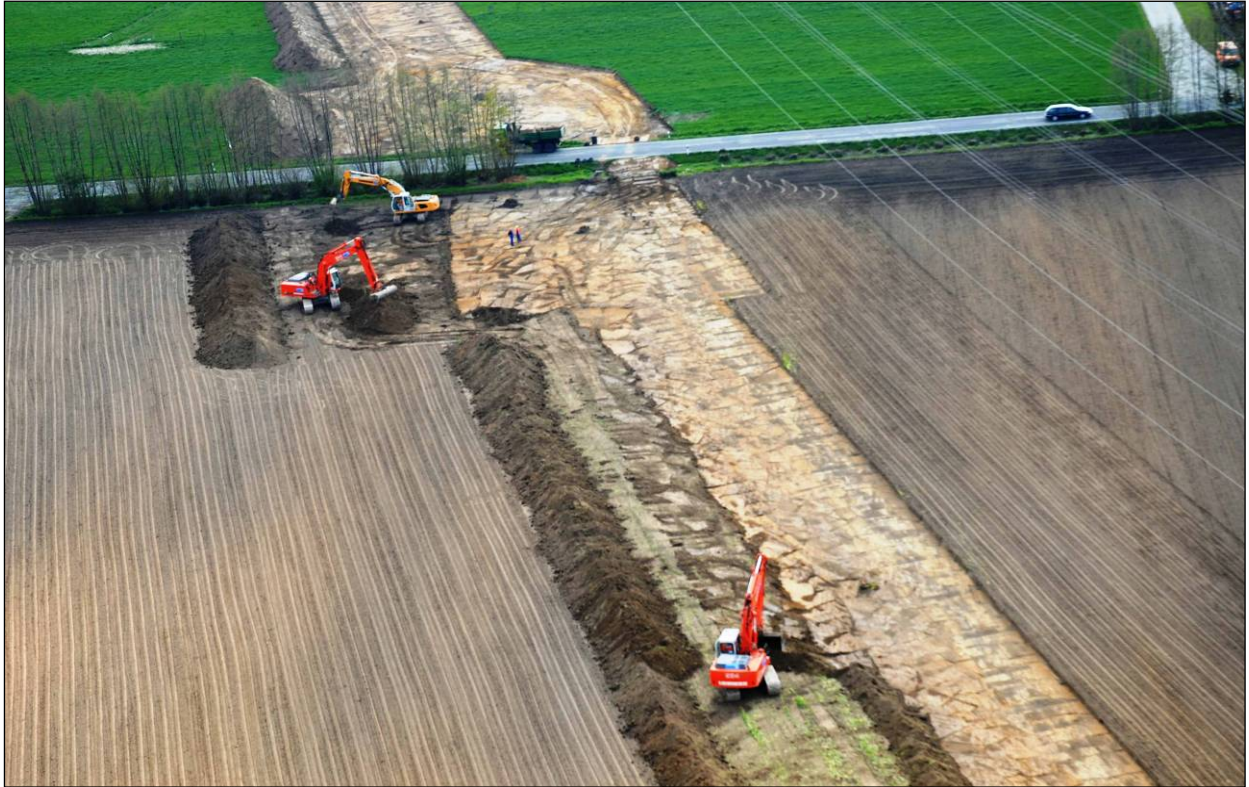
Abbildung 6: Abschieben und Lagern des Oberbodens
