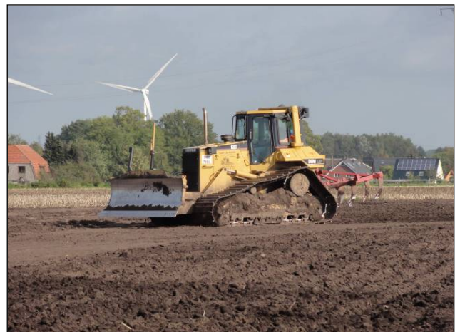
Abbildung 10: Rekultivierung des Arbeitsstreifens
