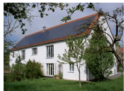
Solarziegel ergeben eine ruhige Dachfläche, wie auf diesem sanierten Wohnhaus in Unterflossing, Lkr. Mühldorf (Planung und Foto: Innenarchitekt Rudolf Mergl)
