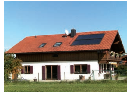
Der gleiche Abstand von Dachflächenfenstern und Kollektoren zur Traufe sorgt hier für ein ruhiges Gesamtbild (Foto: Achim Schröer)
