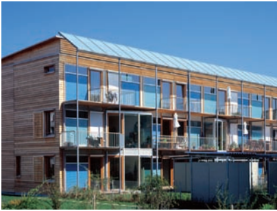
Auf dem „2-Liter-Haus“ in München-Riem werden Kollektoren gleichzeitig als Balkonüberdachung dienen (Planung und Foto: Lichtblau Architekten)
