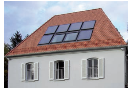
Dachflächenfenster und thermische Kollektoren im selben Format erscheinen auf diesem Wohnhaus in Pullach als ein Gesamtelement (Foto: JNS Dachtechnik)
