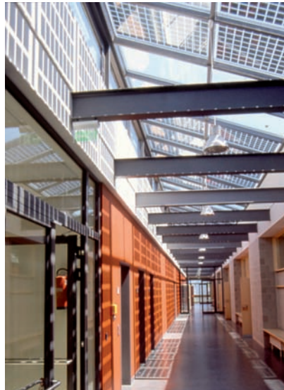
Polykristalline Solarzellen sorgen im Josef-Hofmiller-Gymnasium in Freising für angenehme Belichtung (Planung und Foto: A2 Architekten Koronowski Lautner Roth)
