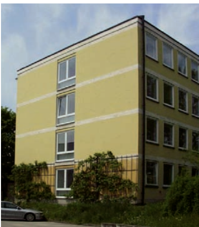
Die sanierte Fassade des Landratsamtes in Landsberg am Lech dämmt und erzeugt gleichzeitig Strom (Planung und Foto: Architekt Klaus Pilz)
