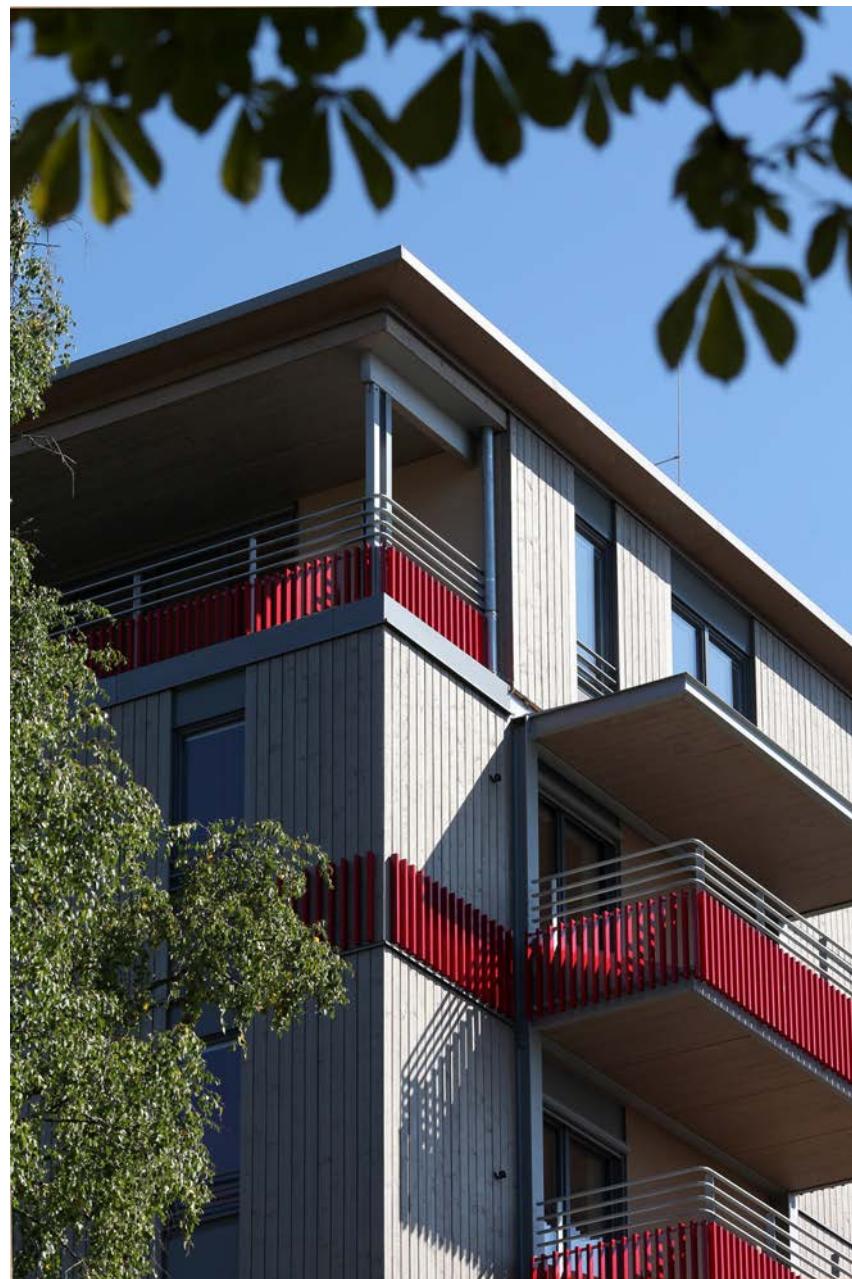
Loggia und Balkon lassen sich auch beim mehrgeschossigen Holzbau wärmebrückenfrei realisieren. Vertikale Lamellen in roter Farbe integrieren die Balkone und beleben die Fassade.
