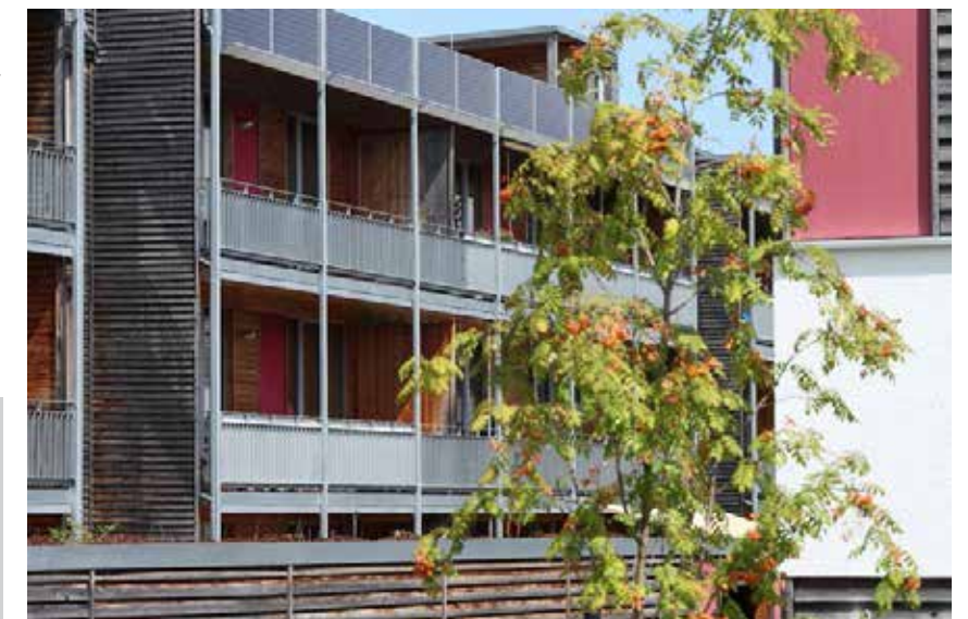
Die Fotovoltaikanlagen nehmen die Gliederung der Brüstungselemente bei den Geschossebenen auf und sind damit unauffällig in das konstruktive Gerüst der Loggien integriert.
