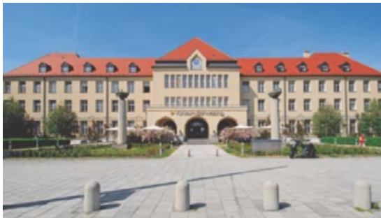
Der Freistaat stellt für Sanierung und Neubau von Gebäuden des Klinikums Schwabing rund 48 Millionen Euro bereit.
